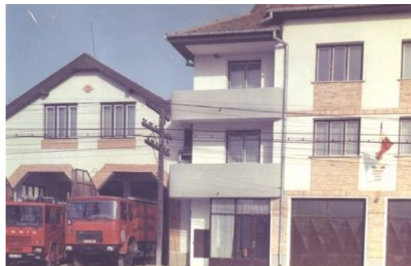
Sediul secției de pompieri Sălard
